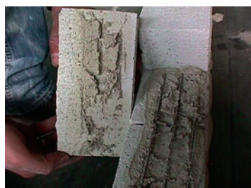
4 | Omhulling van lijmwerk-wapening bij uitvoering met lijmpistool
