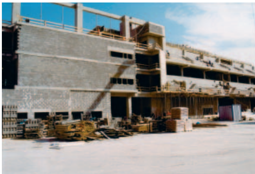
13 | Hoge wanden in gewapend betonblokmetselwerk bij het sportcomplex te Boedapest
